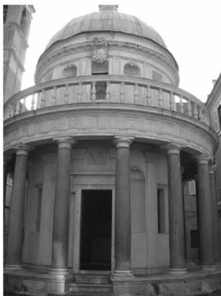
Kupola Firenške stolnice Filippa Brunelleschija (notranji premer 43 metrov) in kupola Tempietta Donata Bramanteja v Rimu (notranji premer le 4,5 metra).
